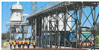
Bocznicą kolejową BRACHÓW
